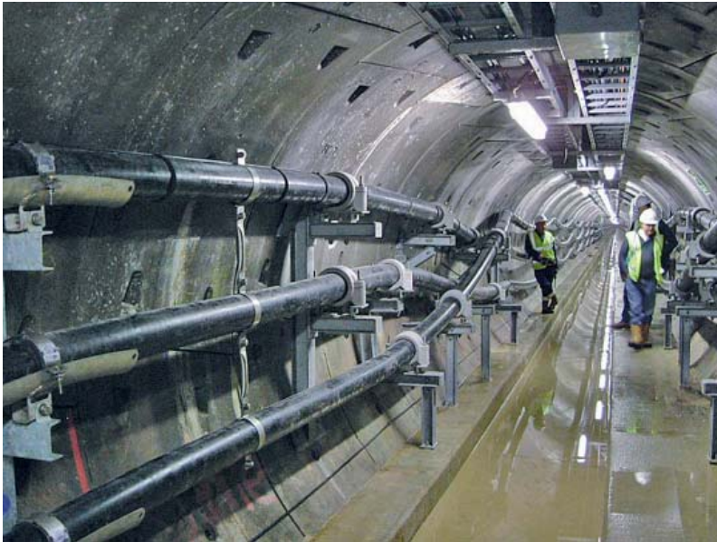
Рис. 5. Пример транспозиции однофазных кабелей
