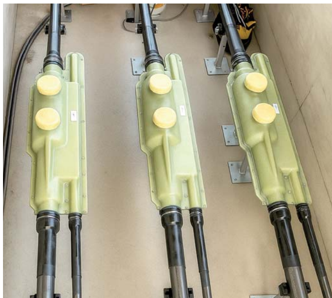
Рис. 2. Муфты транспозиции с выводом экранов коаксиальными проводами
