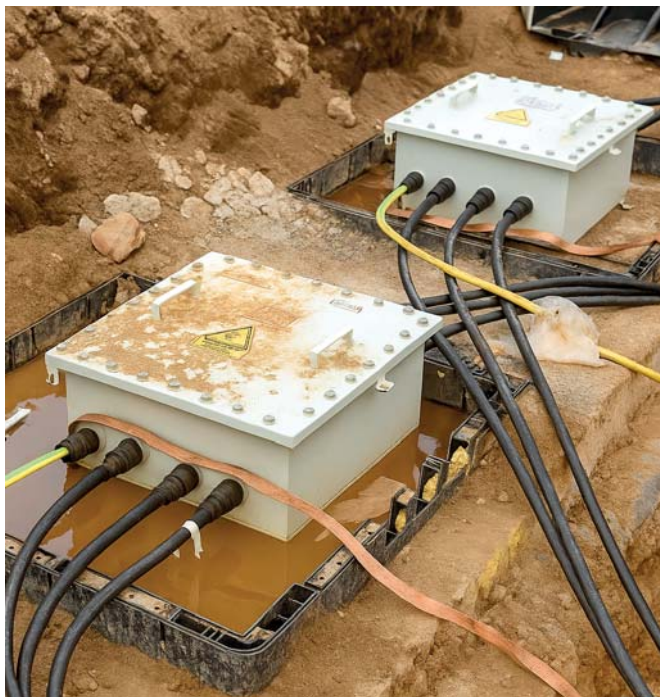
Рис. 6. Коробка транспозиции под одножильные провода (выводы с двух противоположных сторон)
