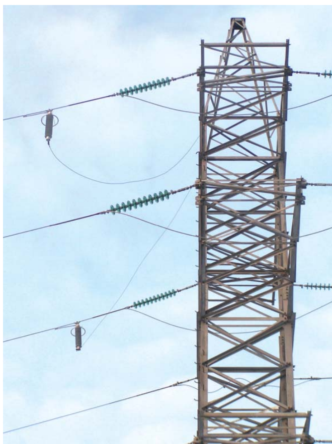
Рис. 4. Подвесные ОПН без искрового промежутка на ВЛ 110 кВ без троса в районе Туапсе
