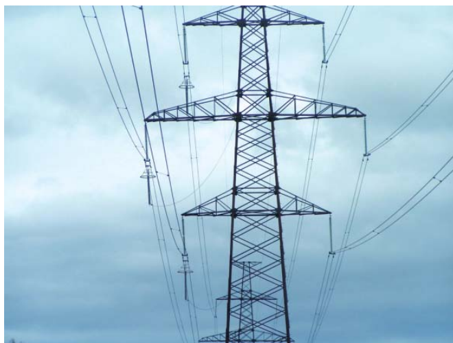
Рис. 4. Подвесные ОПН без искрового промежутка на ВЛ 110 кВ без троса в районе Туапсе
