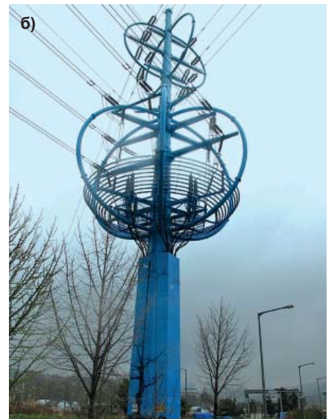
Рис. 6. ПП на опоре ВЛ, имеющей площадку для оборудования, закрытую сеткой: а) решетчатая опора; б) многогранная опора
