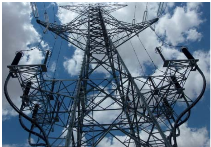
Рис. 3. Двухцепный ПП на опоре ВЛ
