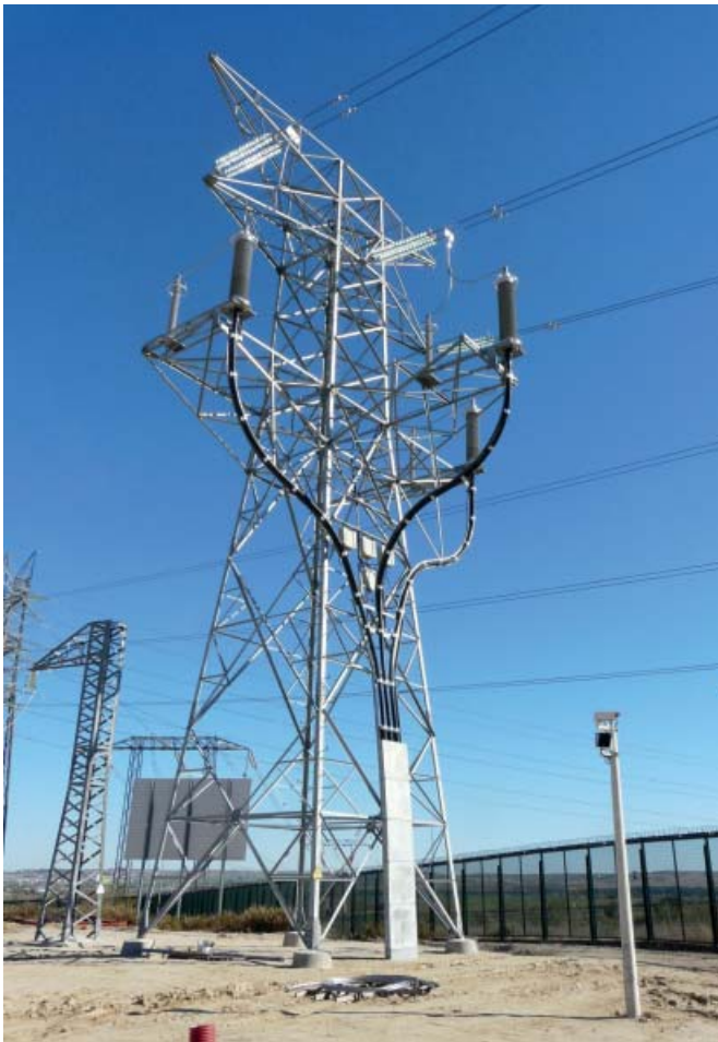
Рис. 4. Одноцепный ПП на опоре ВЛ
