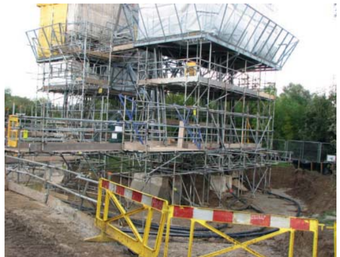
Рис. 5. Сооружение лесов вокруг ПП, выполненного на опоре ВЛ, для последующего монтажа муфт
