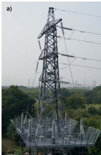
Рис. 6. ПП на опоре ВЛ, имеющей площадку для оборудования, закрытую сеткой: а) решетчатая опора; б) многогранная опора
