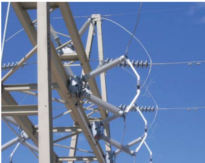
Рис. 11. ПП класса 115 кВ, оснащенный V-образным разъединителем
