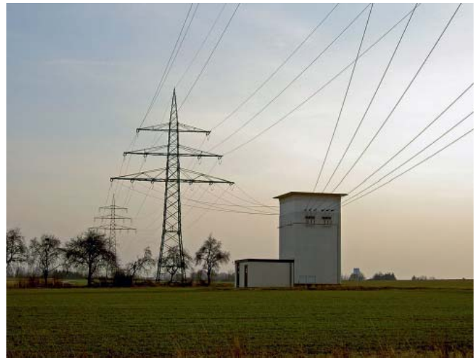
Рис. 2. ПП наземного исполнения в здании
